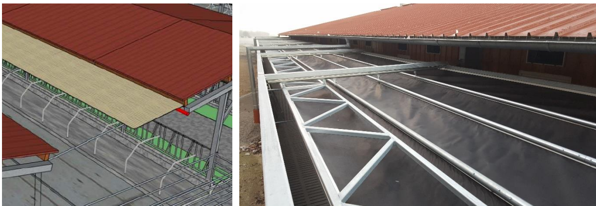
Abb. 9: Beschattungsnetz für temporären, sensorgesteuerten Einsatz (links schematische Darstellung, rechts beispielhafte Ausführung)
