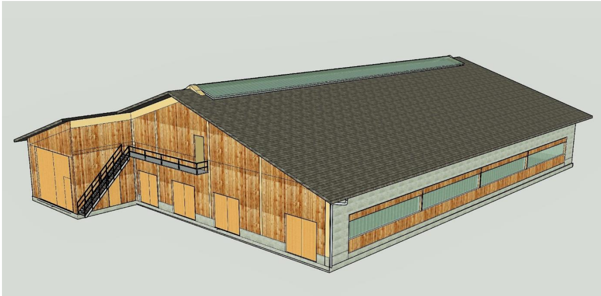
Abb. 13: Von außen zugängliche Besucherempore mit Überblick über das gesamte Haltungssystem
